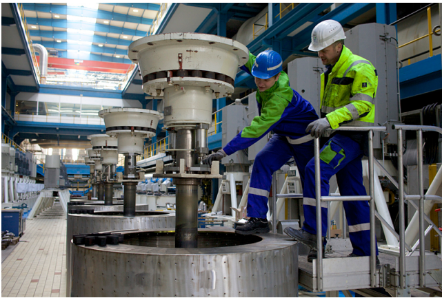
Dank der Preisträger ein Bild aus vergangenen Zeiten: Bisher diente die Zentrifugentrommel als Standfläche bei Montagearbeiten am Kugelkopf.
