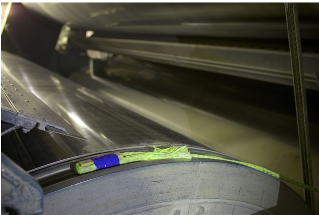
Auflegen des Aufführseils auf den Zylinder
