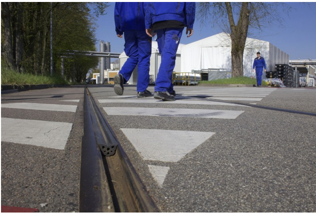
Das prämierte Kautschukprofil im Einsatz auf dem Werksgelände der Firma Freudenberg Sealing Technologies.
