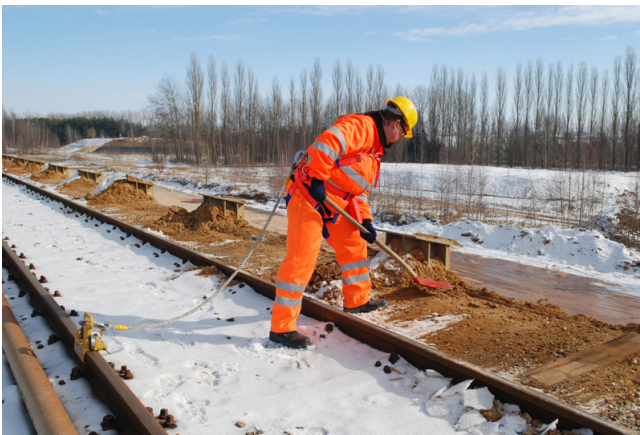
Die neu entwickelte Anschlagvorrichtung wird einfach auf den Schienenkopf aufgesetzt. In der gezeigten Arbeitssituation ist das Verbindungsmittel so bemessen, dass ein Absturz vermieden wird. Foto: bgrci/ Soestmeyer
