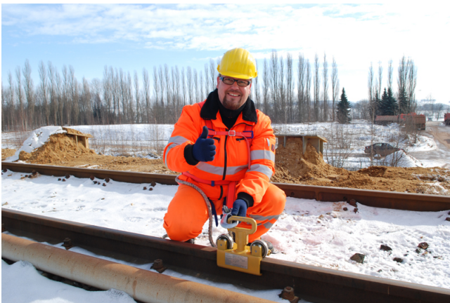
Die Anschlagvorrichtung passt perfekt auf das Gleis, vereinfacht das Arbeiten und wird gerne eingesetzt. Foto: bgrci/ Soestmeyer
